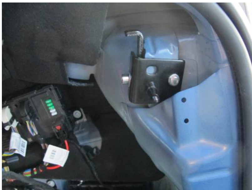
5. Вид завершенной конструкции
